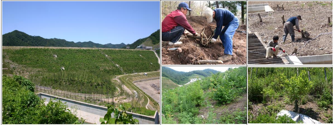
사진 5. 리사이클링 에코녹화공법 적용사례(장흥다목적댐)
