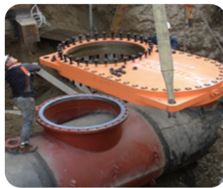
Sandwich Valve 설치
