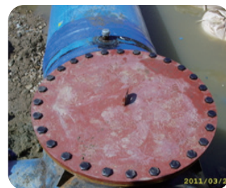
마감 플랜지 설치
