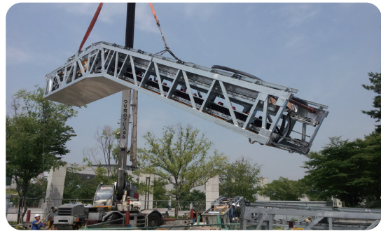
옥외형(트러스 양중 - 크레인 사용)
