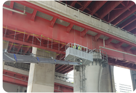
① 클램프 및 와이어로프 설치
