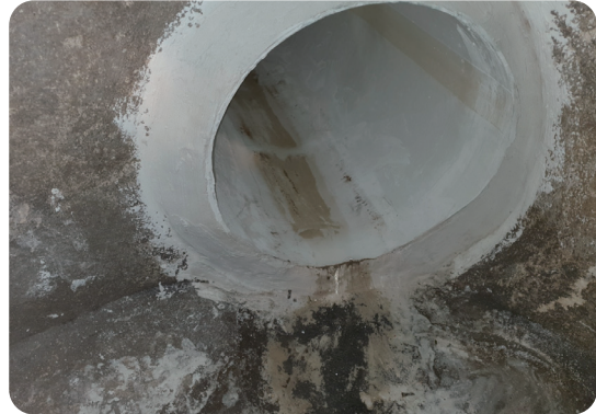
관입구 마무리공 시공사진
