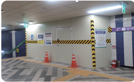
지하철 공사용 내부 가설칸막이 해체 전
