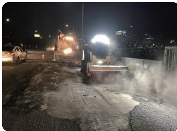
교량 교면방수 바탕처리 전경
