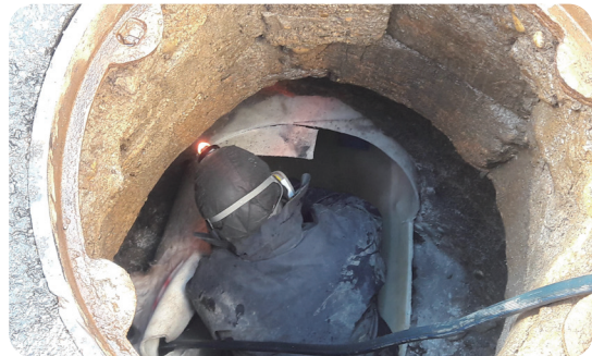
라이닝 튜브 절단 작업
