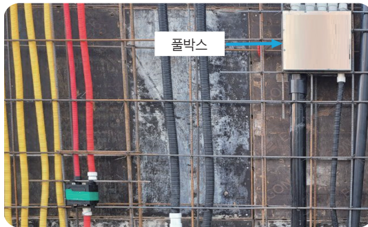
매입 벽면 설치
