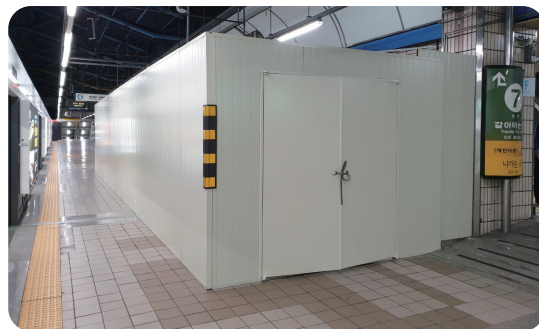
지하철 공사용 내부 가설칸막이 설치 후
