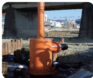
차단 장비 설치
