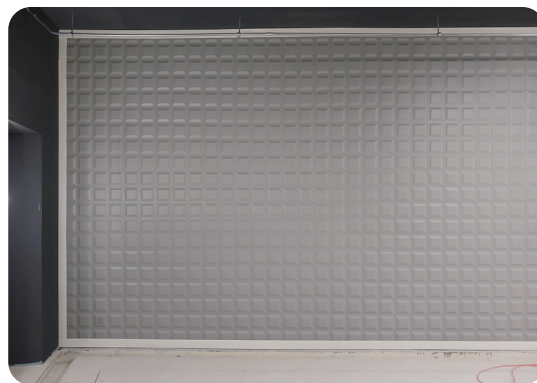
마감패널 및 몰딩 설치
