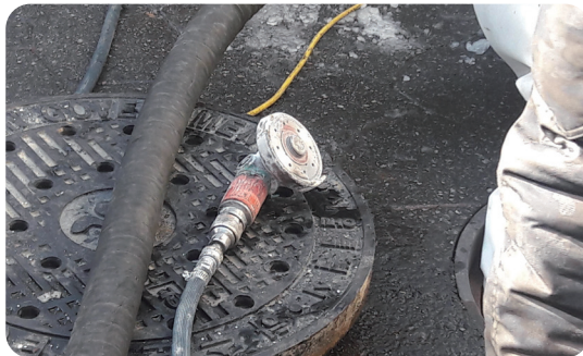
튜브 절단기(컷소) 작업 준비
