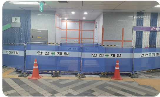
지하철 공사용 내부 가설칸막이 해체 후
